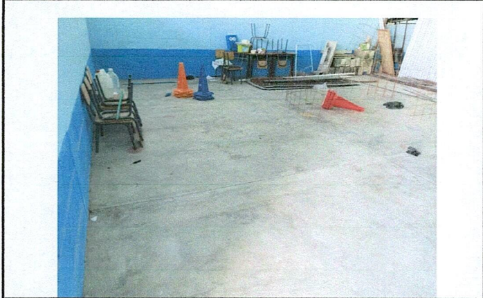
Foto 1: CAMBIO DE PISO Y VENTANAS
