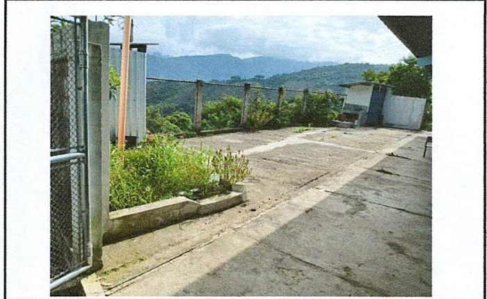
Foto 2: REPARACIÓN DE CERCO O MURO PERIMETRAL
